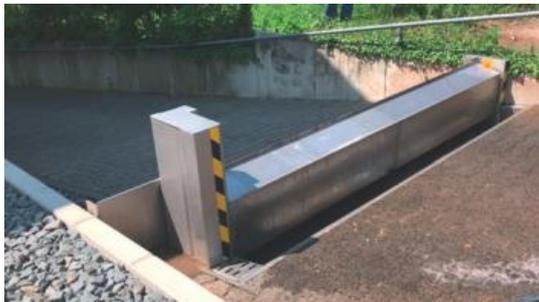
Mobiles Klappschott ([www.klappschott.de](http://www.klappschott.de))
